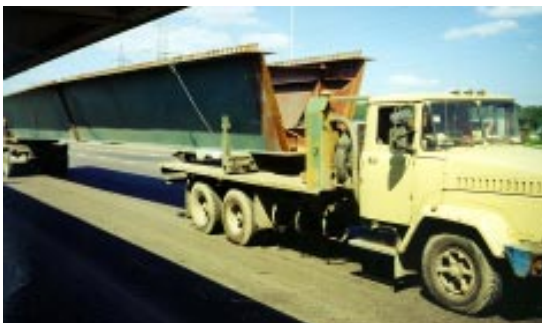
«Тяни-Толкай! конца XX в. Так перевозили фермы для эстакад на строительстве МКАД
